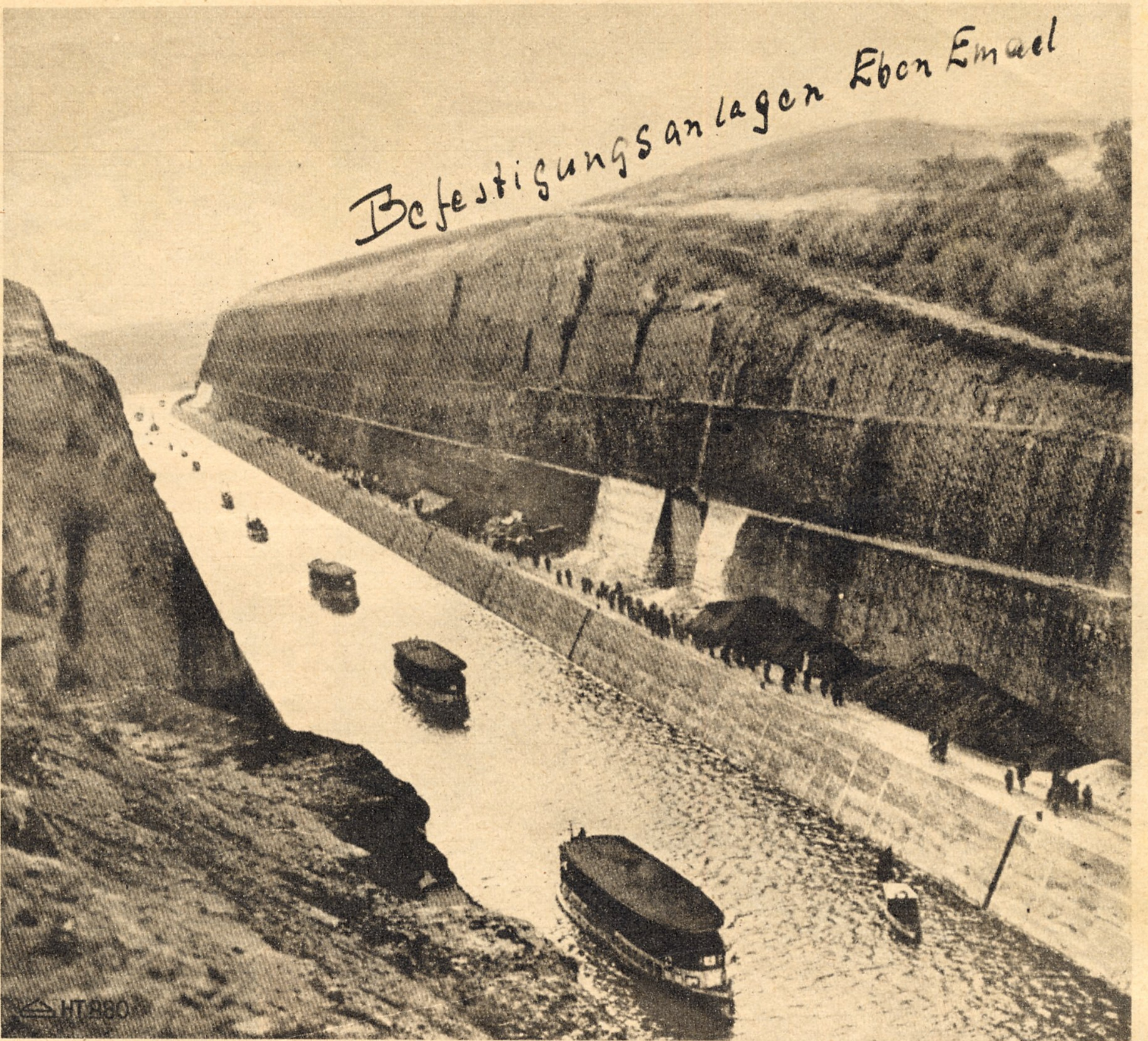
Blick auf den Albert-Kanal, der als ungeheures Hindernis einen wesentlichen Bestandteil des Forts Eben-Emael bildet. Dieser Kanal, der die Verbindung zwischen Maas und Geer herstellt, hat eine Einschnitttiefe von 65 m. Die Aufnahme, die bei der Einweihung des Kanals gemacht wurde, vermittelt dem Betrachter einen ungefähren Eindruck von den Größen- und Stärkeverhältnissen dieses belgischen Bollwerks, das dennoch von einer Handvoll tapferer deutscher Männer in wenigen Stunden in Besitz genommen wurde, so daß bald darauf über der Zitadelle der Festung Lüttich die Hakenkreuzfahne als stolzes Siegeszeichen flattern konnte
